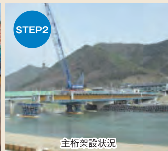
主桁架設状況
