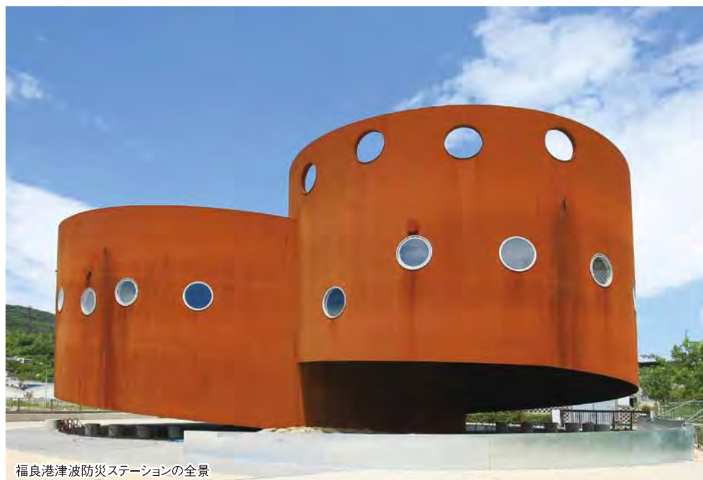
福良港津波防災ステーションの全景
