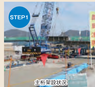
主桁架設状況
