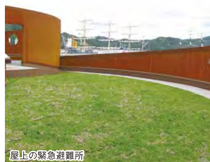
屋上の緊急避難所
