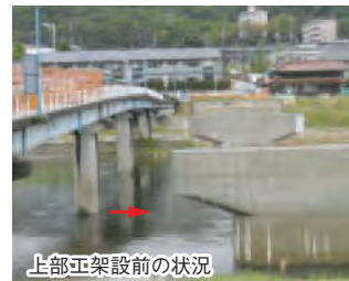
上部工架設前の状況
