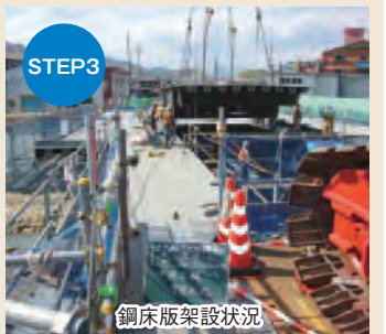
鋼床版架設状況
