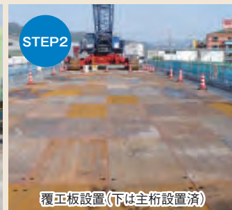
覆工板設置(下は主桁設置済)
