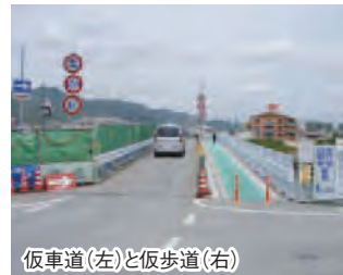
仮車道(左)と仮歩道(右)
