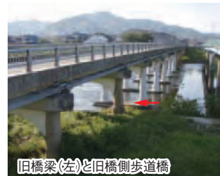
旧橋梁(左)と旧橋側歩道橋
