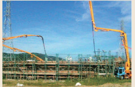
OD槽コンクリート打設状況
