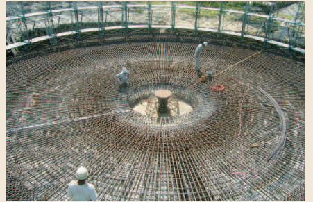
最終沈殿池配筋状況
