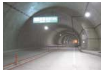
消費電力の少ない照明灯を採用した七坂トンネル
