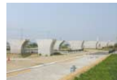
整備が進む東播磨南北道路整備事業 （【仮称】加古川中央ジャンクション付近）
