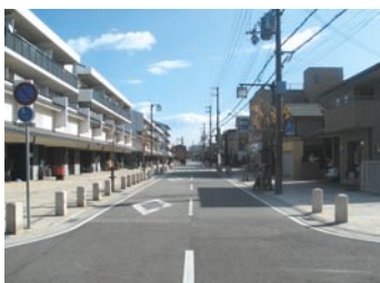
整備された築地南城内線
