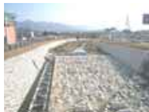
アンカー付自然石積と魚道
