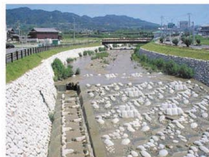
完成 県道より上流 農業井堰
