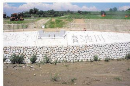
完成 細川西第1橋A2橋台
