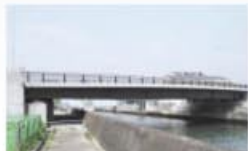
国道250号（仮称）飾摩バイパス飾摩大橋
