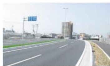
舗装工事が完了した飾磨バイパス
