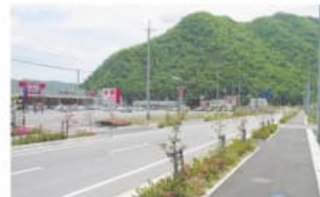
大型店舗の開業等まちづくりが進む
