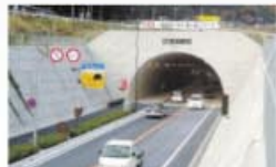
国道176号鐘ヶ坂バイパス 新鐘ヶ坂トンネル
