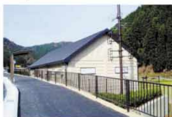
景観に配慮した電気室
