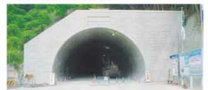
槻坂トンネル龍野側坑門
