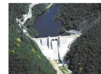
順調に建設が進み試験湛水を行っている石井ダム（今年5月）
