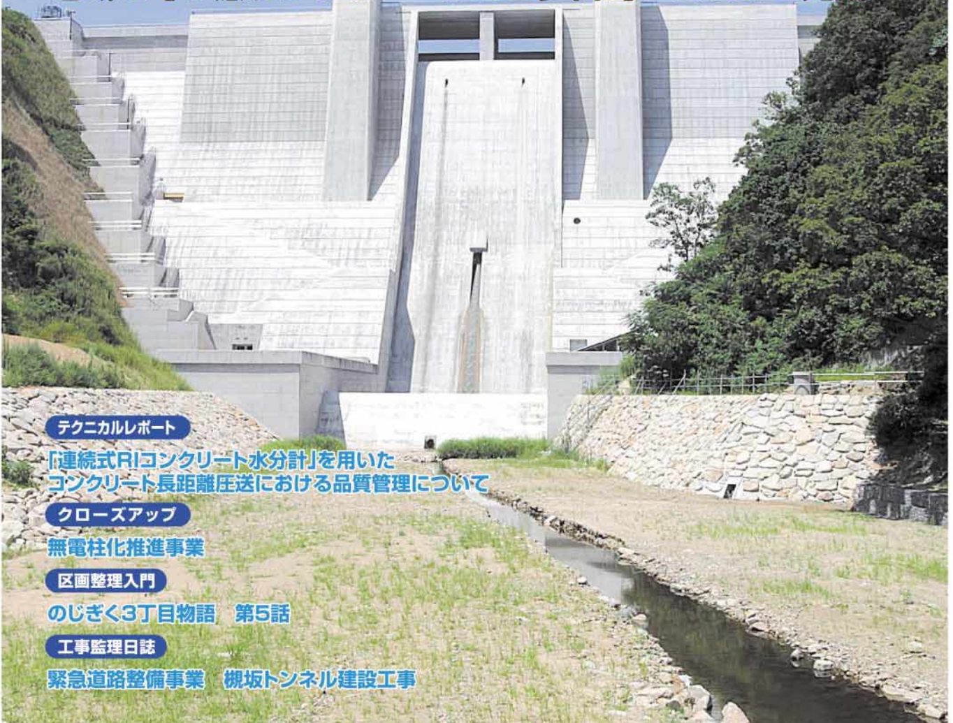
完成した石井ダム、今後神戸のまちを守り続けます
