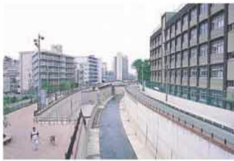
改修された新湊川
