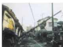
阪神大震災では倒れた電柱が避難路をふさぎました
