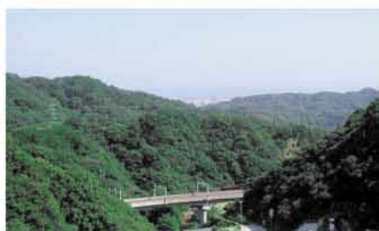
ダム天端より大阪湾を望む
