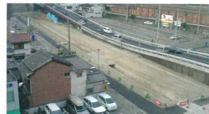
撤去後の状況
