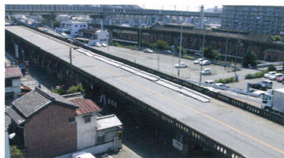
撤去前の状況
