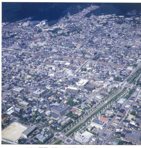
まちの再興が進んだ芦屋西部地区の現況
