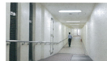
現在の連絡通路の様子
