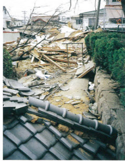
倒壊家屋でふさがれた道路
