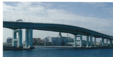
完成した連絡橋
