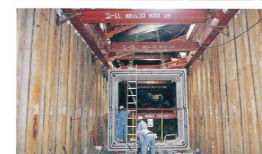
開削工法による工事の様子
