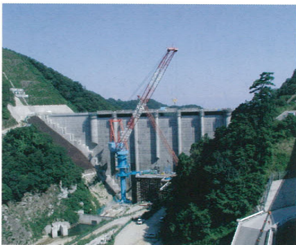
石井ダム（上流側より）
