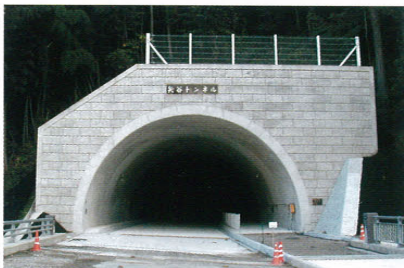
矢谷トンネル完成写真（起点側）
