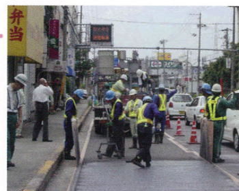
光触媒舗装施工状況
