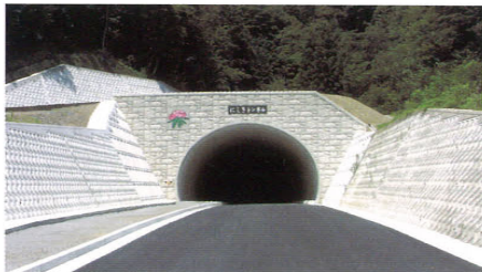
にしきトンネル完成写真
