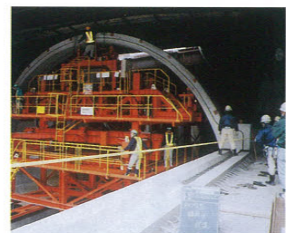
3.架設架台にて移動
