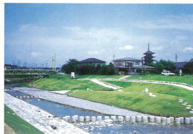
工事完成直後のふるさと橋周辺でもコンクリートを用いる必要がある箇所は、顔料を混ぜて肌色に近い色にし、周囲の景観に合わせています。
