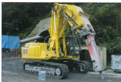
VE提案 機械掘削用超大型ブレイカー
