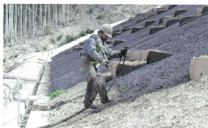
連続繊維緑化基盤工施工状況
