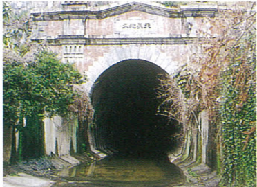
震災を受ける前の会下山トンネル吐口側坑口
