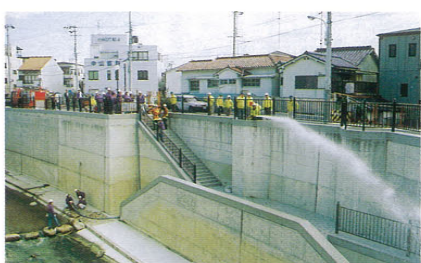
新湊川で消防訓練を行う地元消防団
