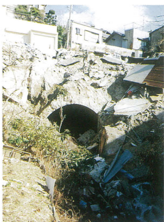
会下山トンネル吐口側坑口被災状況
