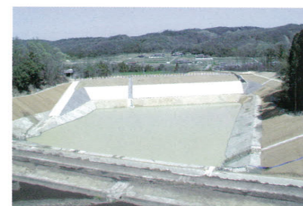
E調整池完成写真
