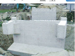
(町)高山里所線 橋梁整備工事の積算、工事監理を受託
