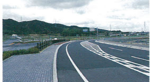
西淡三原ICに直結する西路バイパス
