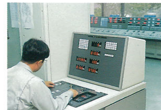
ダム湖と魚道をつなぐ開門の開閉はダム管理事務所にある機器により遠隔操作
