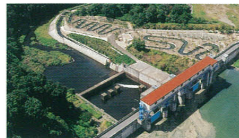
魚道にはさまざまな工夫が施されている
