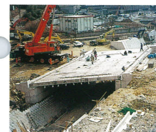
（一）電泉那波泉道路改良工事では積算と工事監理を受託（電泉橋）
