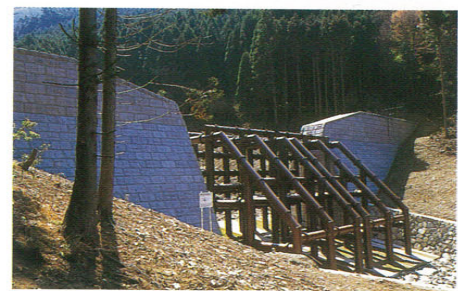
自然環境への影響を少なくするために採用された透過型の格子型鋼製ダム(鋼製部重量185t)
