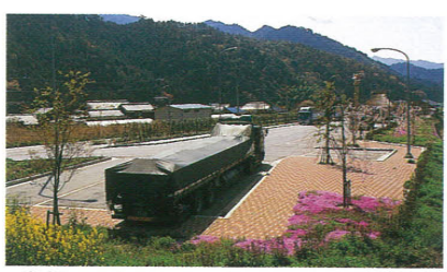
一年を通して多くのドライバーに利用されている国道312号吉富地区のチェーン着脱場
