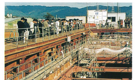
現場研修(SRC構造の橋脚施工)
