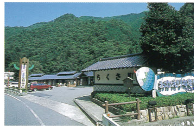
町の南の入り口にある道の駅ちくさ
