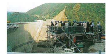
試験湛水直前の温井ダム
