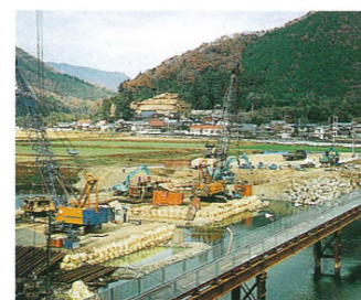
赤松橋災害関連復旧工事(上部町)
