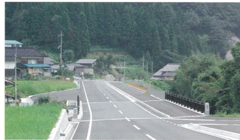
町道河内線はまもなく過疎代行事業で完成
