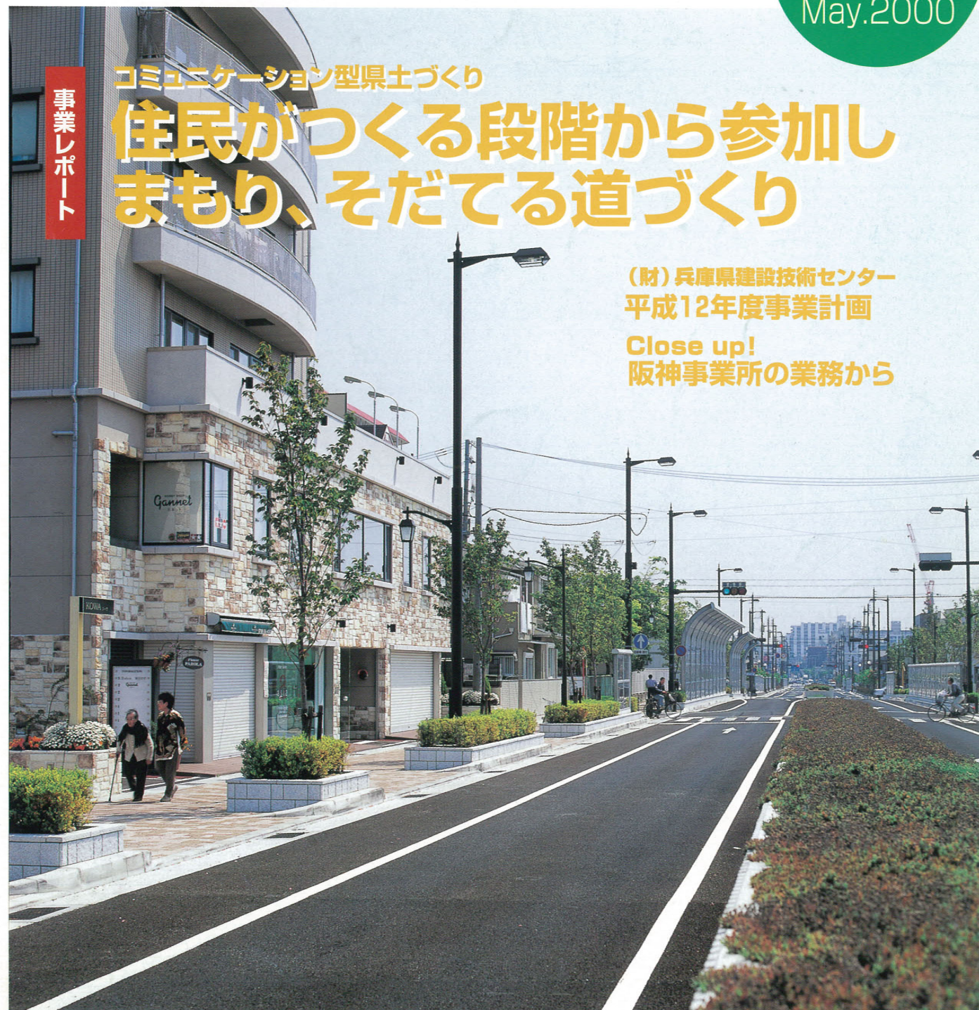
西宮市が自治会との協議を重ね、環境や安全性・景観に配慮し完成した山手幹線(西宮市寿町)
