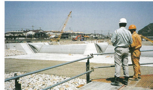
河川改修にともなう市川瀬下堰下部工工事の現場監理業務を受託(市川工事現場にて)
