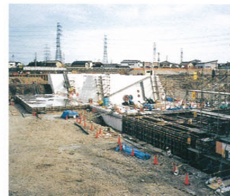
市川潮止堰の第1期工事(左岸側の状況)
