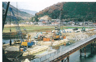
町道赤岩線 赤松橋災害関連復旧工事(上郡町)
