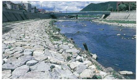
河床の岩盤掘削で生じた岩塊を護岸に利用して自然景観との調和を図る
