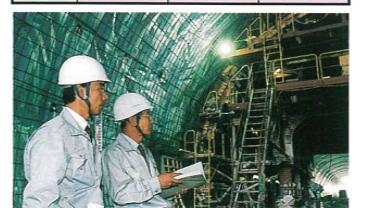
平成8年度より積算、現場監理業務を受託してきた（主）相生山崎線角亀トンネル
