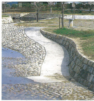
車椅子で水辺に近づくことができるようスロープを設置。
