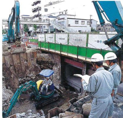
河川の二層化を進める高羽川災害復旧助成事業では工事監理を受託(国道2号と交差部にて)
