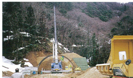
蘇武トンネルの村岡側坑口(着工当時)
