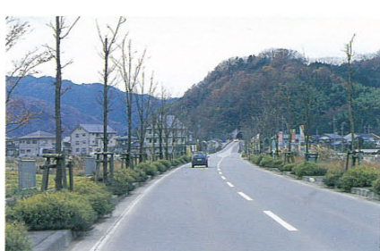
日高バイパスの沿線には新しい市街地が形成されつつある
