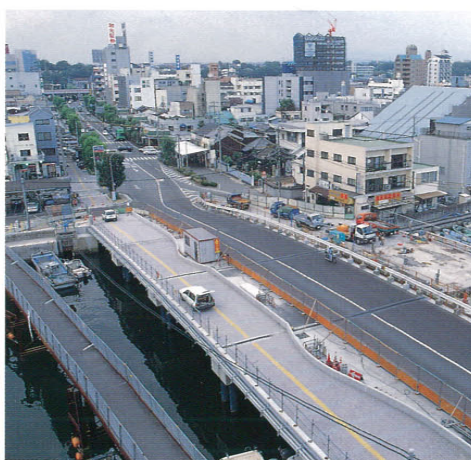
幅員30mに改築中の錦江橋
