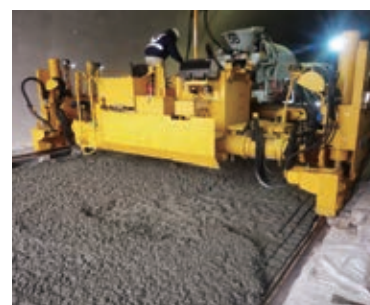
コンクリート舗装施工状況
