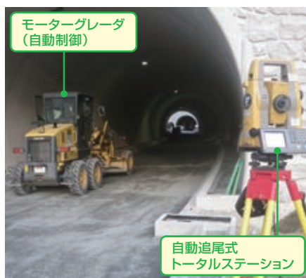
ITC建機による路盤工
