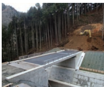
着工前の川代3号トンネル (起点側坑口)
