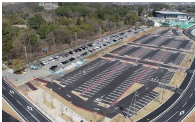
前期工事完成
