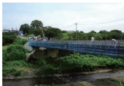
篠山山南線改良工事(井出屋橋歩道橋)
