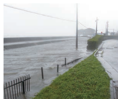
海水が流入したスラッジセンター東側の道路
