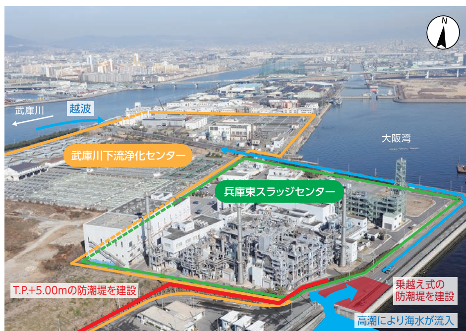
武庫川浄化センター及び兵庫東スラッジセンター航空写真 スラッジセンター南側から既設防潮堤の縁を回り込むように海水が流れ込んだ。また、西側を流れる武庫川からの越波による浸水も発生した。
