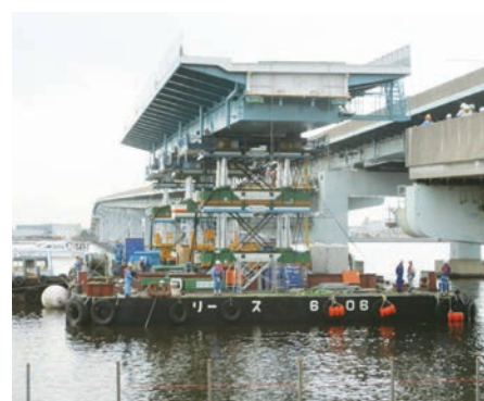
桁をジャッキアップして北側より進入
