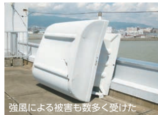
強風で飛ばされた換気口カバー
