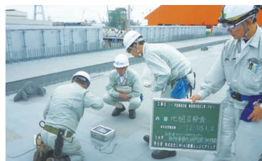
現場立会(新桁製作)
