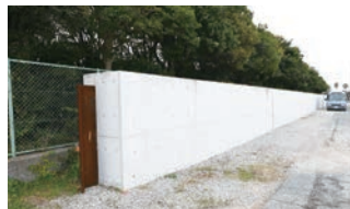
建設中の防潮堤
