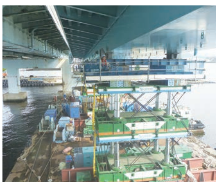
潮待ち+ジャッキダウンにより桁を据付
