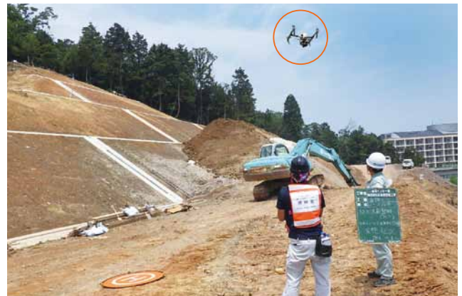
豊岡病院駐車場整備工事（ドローンによる出来形確認）
