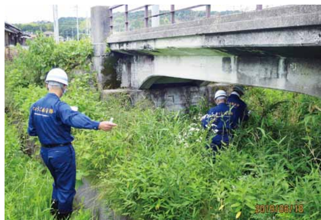
市町橋梁の経過観察
