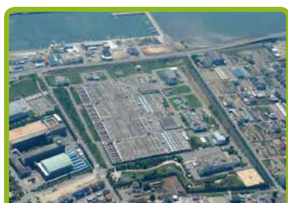
揖保川浄化センター(姫路市)
