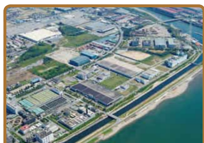
加古川下流浄化センター(加古川市)
