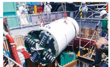
工 事 名: 甲山幹線(第2工区)布設替工事 委 託 者: 姫路市 受託内容: 積算・工事監理
