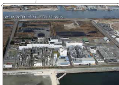
兵庫西スラッジセンター(姫路市)
