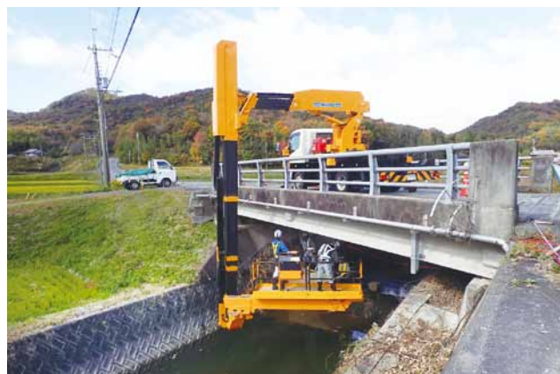
橋梁点検車による点検状況
