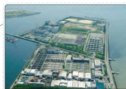
武庫川下流浄化センター(尼崎市)
