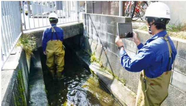
タブレットによる直営点検の状況
