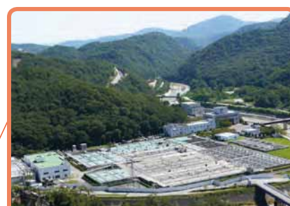
武庫川上流浄化センター(神戸市)
