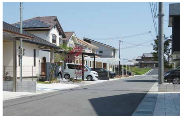
加西市 西高室地区
