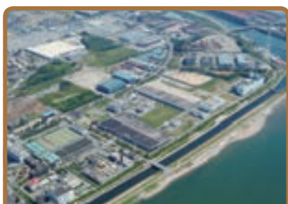
加古川下流浄化センター(加古川市)
