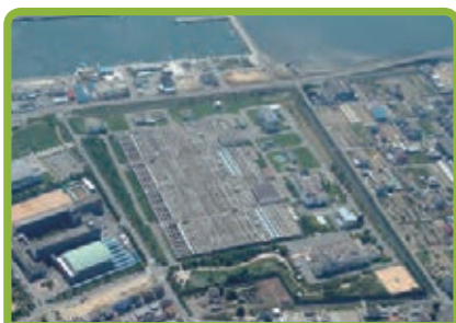
揖保川浄化センター(姫路市)
