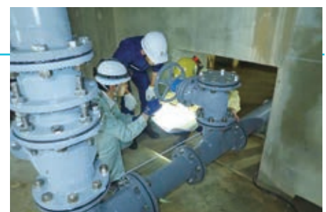
浄水場送水ポンプ井改修工事
