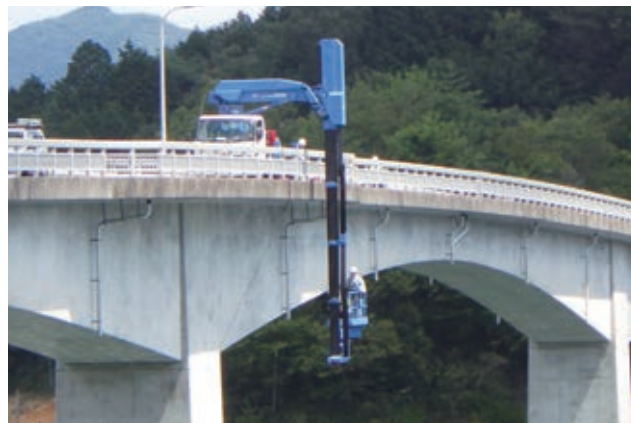
橋梁点検の状況
