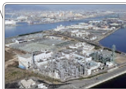
兵庫東スラッジセンター(尼崎市)
