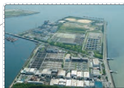
武庫川下流浄化センター(尼崎市)
