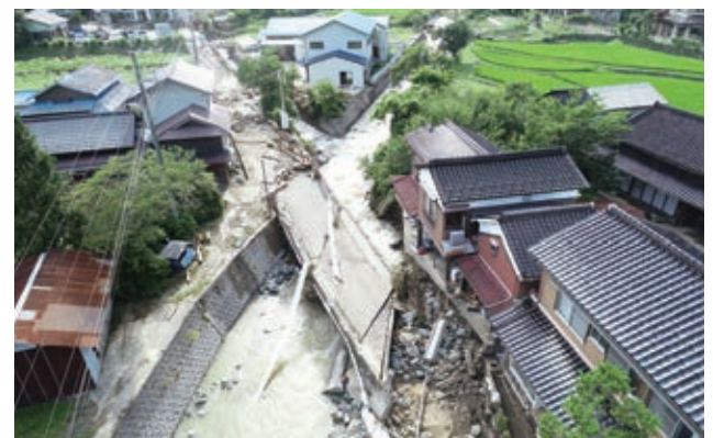
ドローンを活用した被災状況調査
