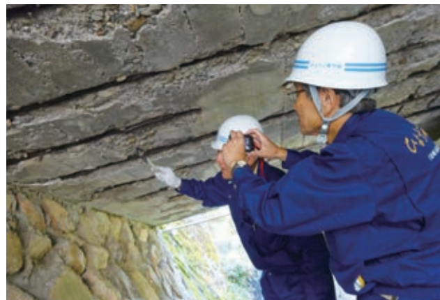
市町橋梁の経過観察
