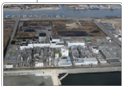
兵庫西スラッジセンター(姫路市)
