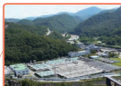
武庫川上流浄化センター(神戸市)
