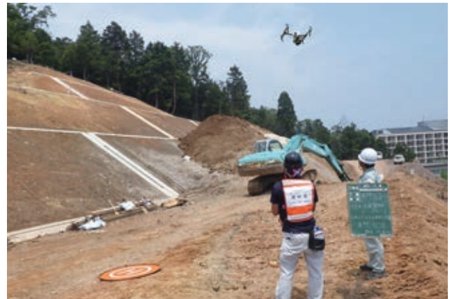
豊岡病院駐車場整備工事（ドローンによる出来形確認）
