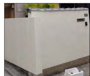
塀瓦（丸瓦）を使用したCB塀
