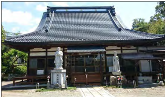
金属瓦 (ガルバニウム鋼板/ステンレス鋼板) (写真は日本スチルス工業(株)の「しあわせルーフ」)
