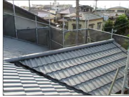
高分子繊維強化セメント瓦 (写真は富士スレート(株)の「エアルーフ」)
