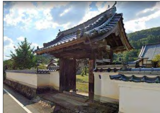
漆喰壁に似せた塗装仕上げ (写真は、モルタル下地に塗装したもの)
