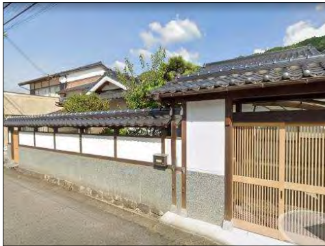
漆喰壁に似せた塗装仕上げ (写真は、ケイカル板に塗装したもの)
