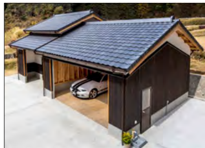
(事例2) 樹脂混入繊維補強軽量セメント瓦
