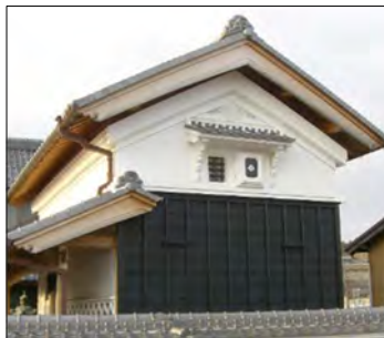
漆喰壁・板張り
