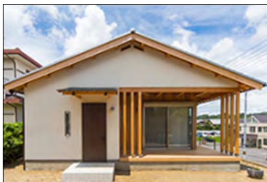
漆喰壁に似せた左官仕上げ (写真はアイカ工業の「ジョリパット」)
