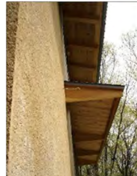
土壁に似せた左官仕上げ (写真は「モルタル (リシン) 掻き落とし」)
