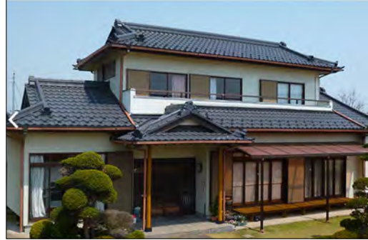
軽量金属瓦 (GL 鋼板/ステンレス鋼板) (写真は(株)カナメの「カナメルーフ」)
